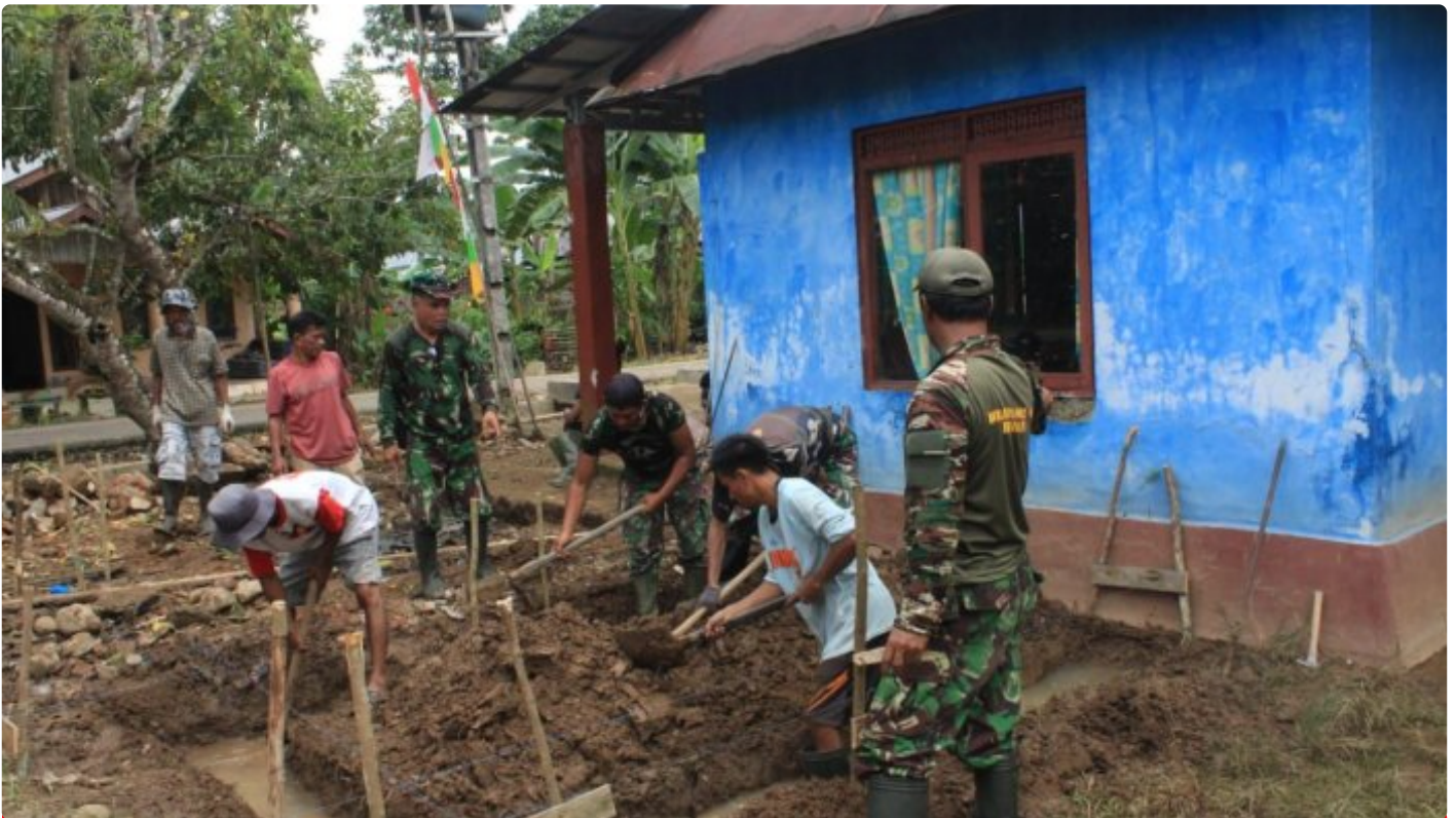
Rehab Musholla Darul Hair Mulai Dikerjakan Oleh Satgas TMMMD ke-116 Kodim 1002/HST
