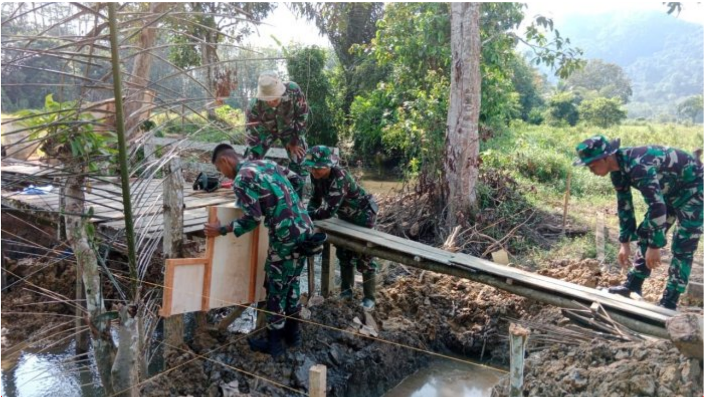
Satgas TMMD ke-116 Kodim 1002/HST Dikerjakan Jembatan
